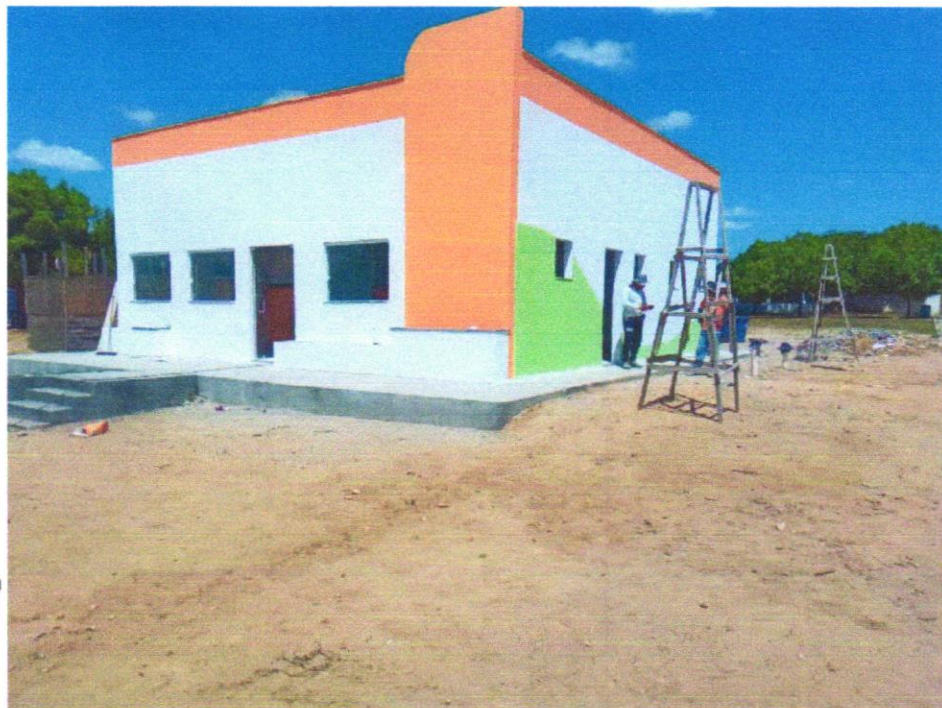
FOTO 10 – APLICAÇÃO MANUAL DE PINTURA COM TINTA LÁTEX ACRÍLICA EM PAREDES, DUAS DEMÃOS. AF_06/2014
